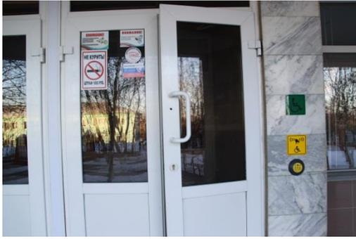
Рис. 5 Дверь (входная) с кнопкой вызова помощника
